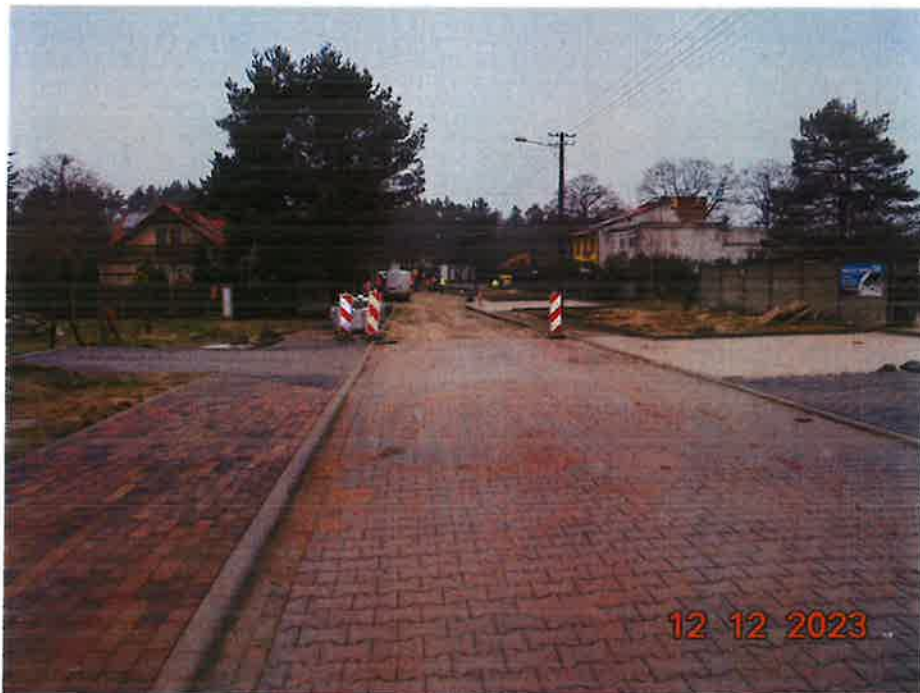
Przebudowa ul. Bursztynowej, Brylantowej, Szmaragdowej i Wilczej
