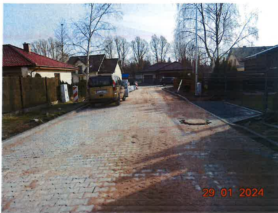
Budowa dróg wewnętrznych na Osiedlu Zacisze wraz z budową ścieżki pieszo-rowerowej
